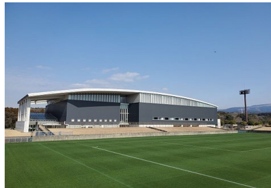
● 大津町総合体育館
