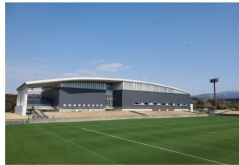
● 大津町総合体育館
