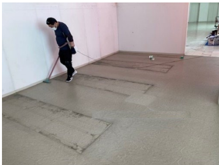
事例2 階段横床面 剥離洗浄+ワックス塗布
