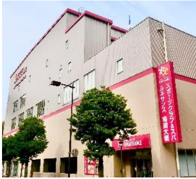
ルネサンス福岡大橋 24
