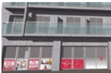
元氣ジム/リハビリステーション湘南深沢外観イメージ
